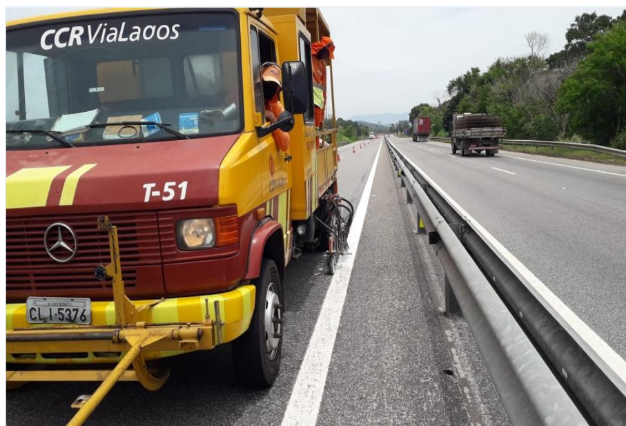
FOTO 27 – Pintura de faixa do canteiro central – km 28+000
