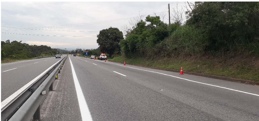
FOTO 29 – Serviço de atendimento com foco na sinalização de proteção
