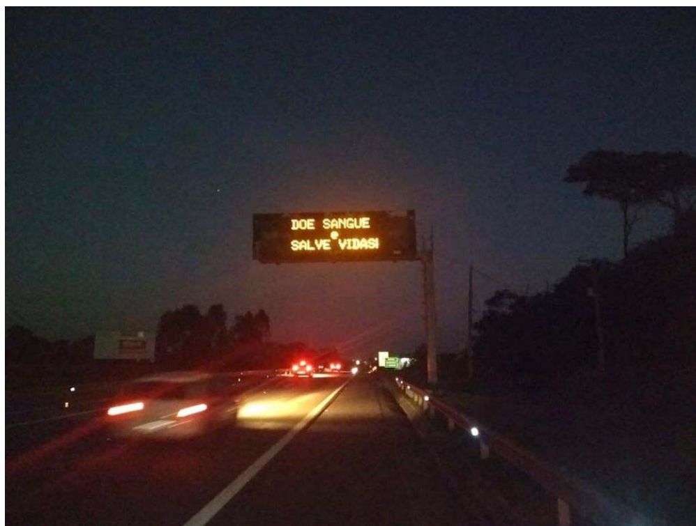
FOTO 26 – Sinalização horizontal, vertical, sinalização refletiva e aérea
