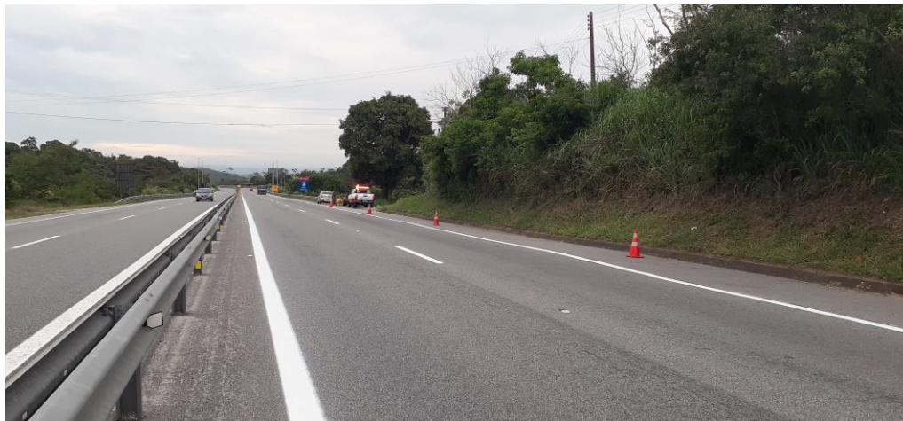
FOTO 40 – Serviço de atendimento com foco na sinalização de proteção
