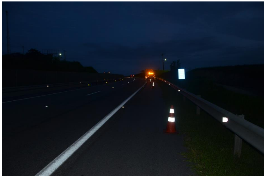
FOTO 21 – Atendimento socorro mecânico com foco na sinalização de proteção (cones e painel de desvio) - Km 46+000
