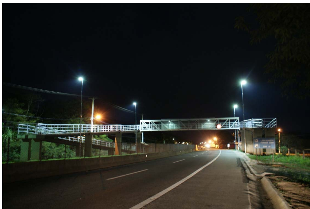
FOTO 03 - Passarela com foco na iluminação - Km 13+000
