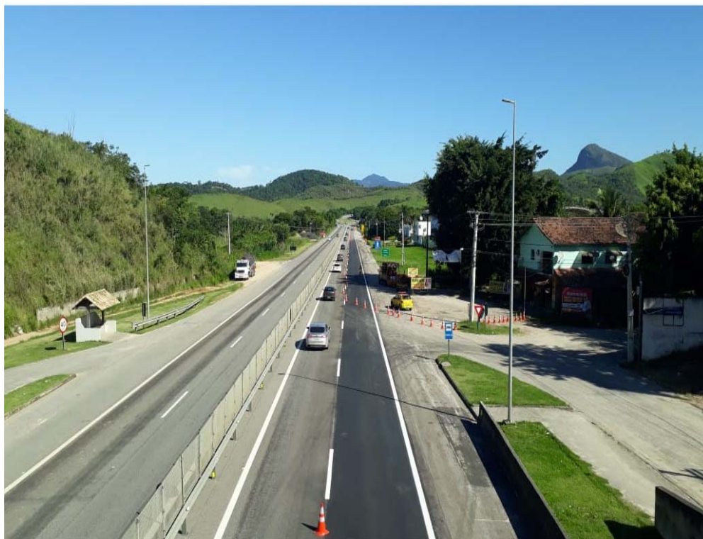
FOTO 27 - Sinalização de segurança obra de Recuperação do Pavimento - Km 3+500
