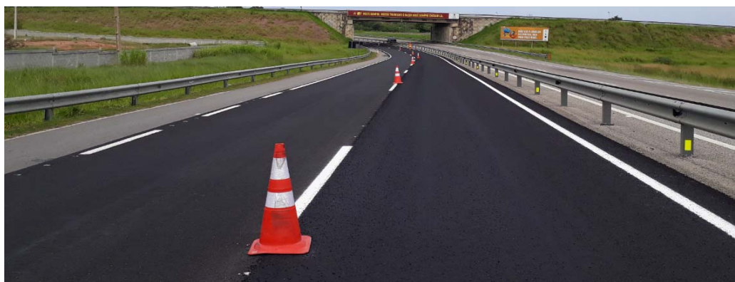
FOTO 28 - Sinalização de segurança obra de Recuperação do Pavimento - Km 56+000
