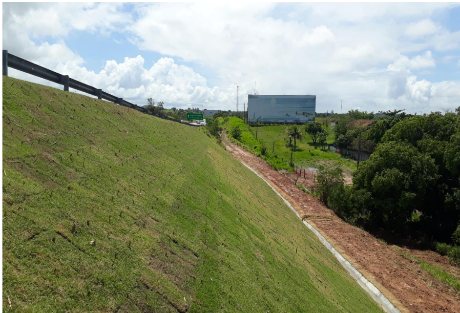
FOTO 32 - Obra de Recuperação de Talude com a solução de retaludamento e replantio (fim) - Km 30+080
