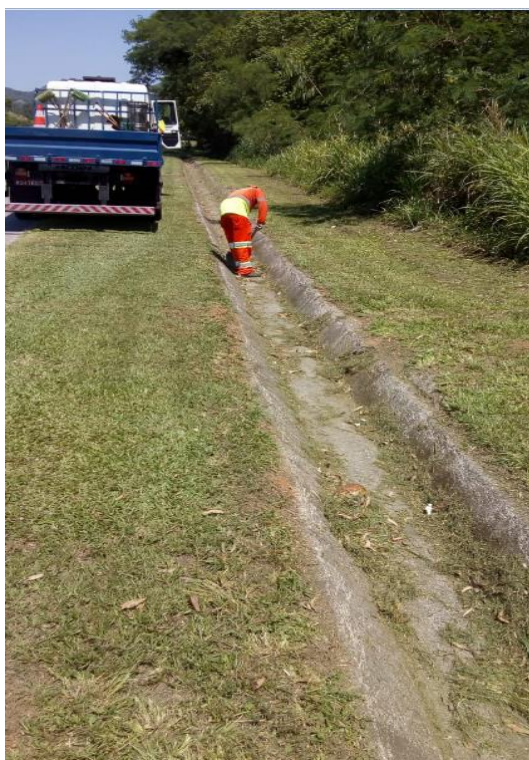
FOTO 29 - Limpeza Valeta de Corte - Km 19+000
