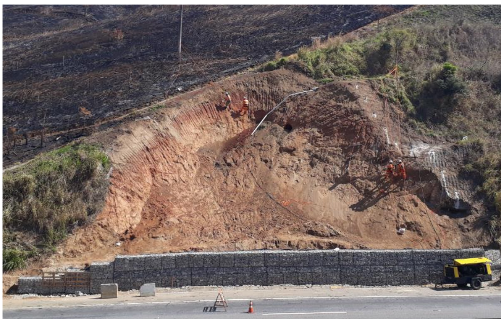
FOTO 33 - Obra de Recuperação de Talude com a solução de solo grampeado (início) - Km 09+760
