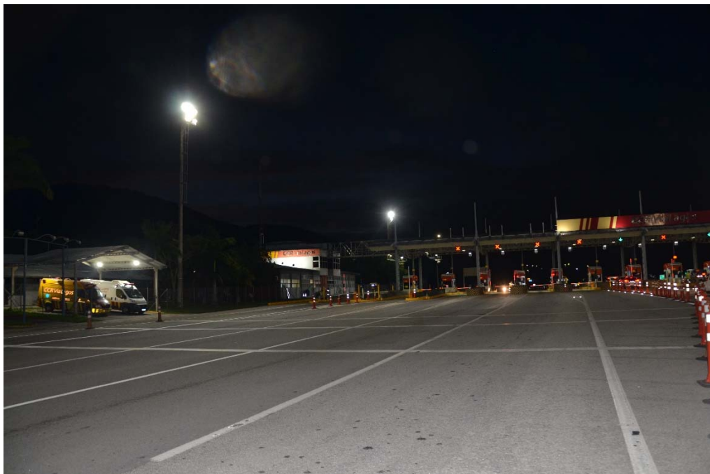
FOTO 07 – Praça de Pedágio - Km 21+500
