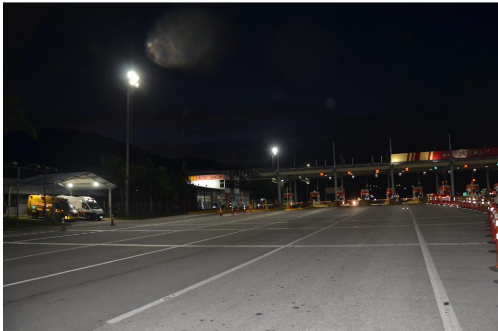
FOTO 07 – Praça de Pedágio - Km 21+500
