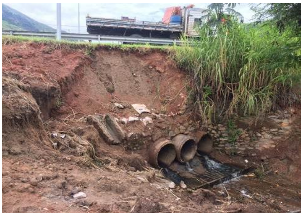
FOTO 35 - Obra de ampliação do sistema de drenagem (início) - Km 09+370
