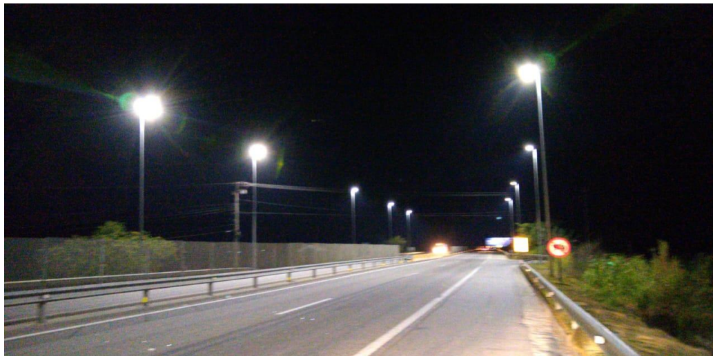
FOTO 05 – Travessia de pedestre com foco na iluminação - Km 08+000
