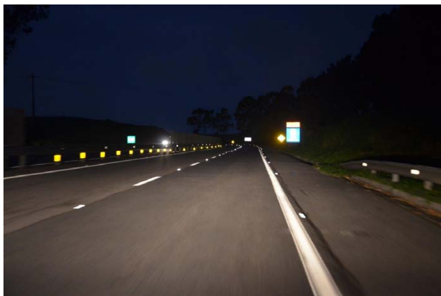
FOTO 23 – Sinalização horizontal, vertical e sinalização refletiva - km 42+000
