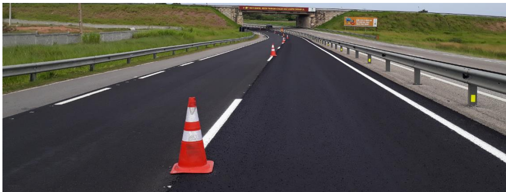
FOTO 38 - Sinalização de segurança obra de Recuperação do Pavimento - Km 56+000
