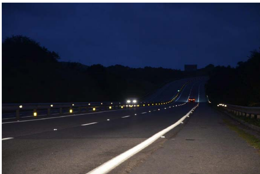
FOTO 22 – Sinalização horizontal e sinalização refletiva - km 44+000
