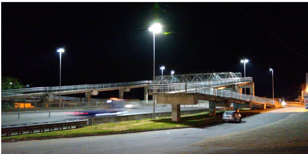
FOTO 01 - Passarela com foco na iluminação - Km 03+000
