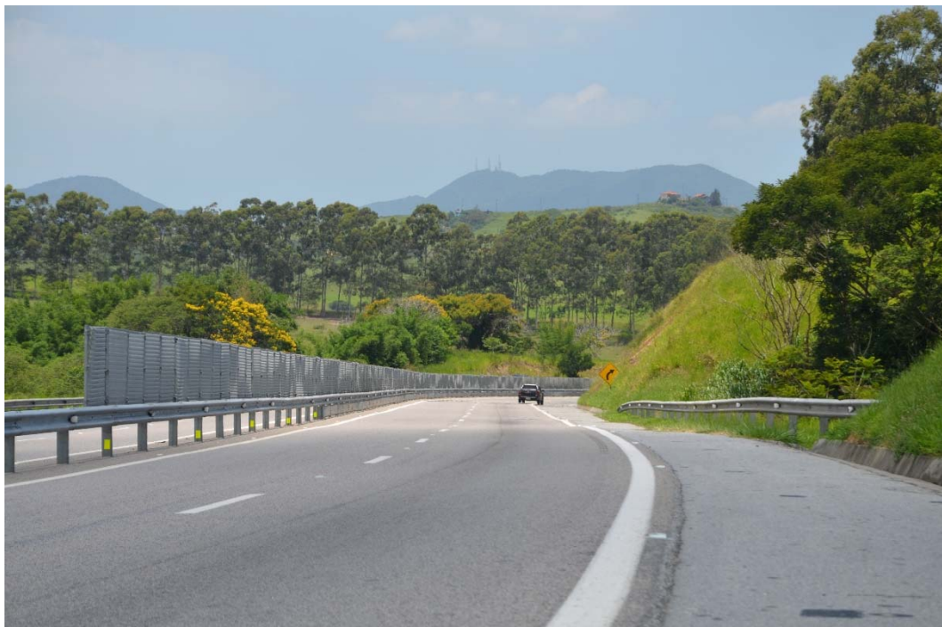
FOTO 31 – Sinalização horizontal - km 42+000
