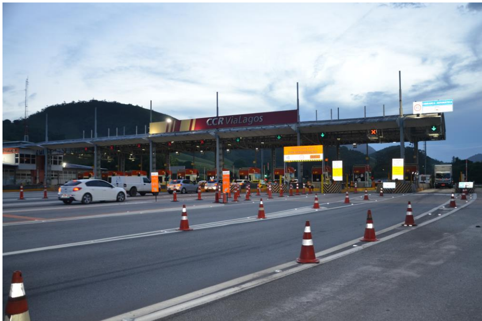
FOTO 09 – Praça de Pedágio - Km 21+500
