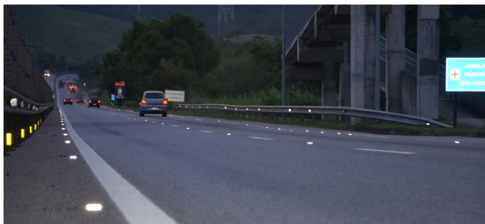
FOTO 24 – Sinalização horizontal, vertical e sinalização refletiva - km 12+000
