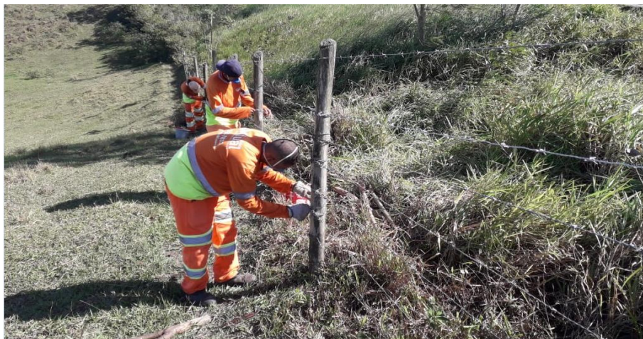
FOTO 30 – Reparo de cercas
