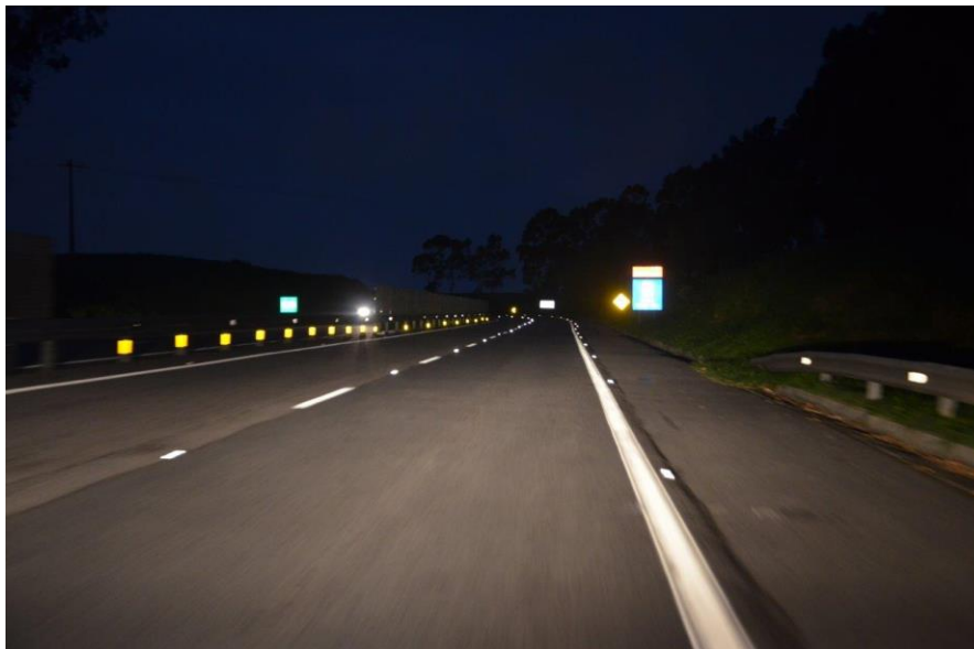
FOTO 23 – Sinalização horizontal, vertical e sinalização refletiva - km 42+000
