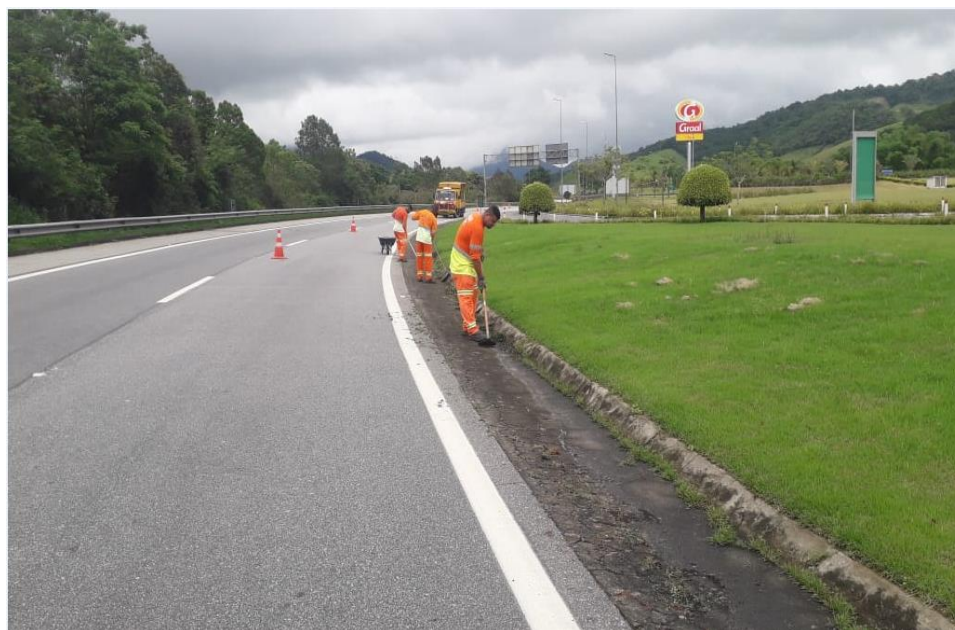
FOTO 28 – Serviço de conserva nos retornos – km 23+000
