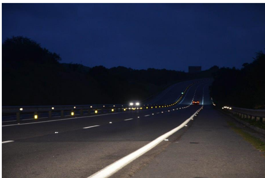
FOTO 22 – Sinalização horizontal e sinalização refletiva - km 44+000
