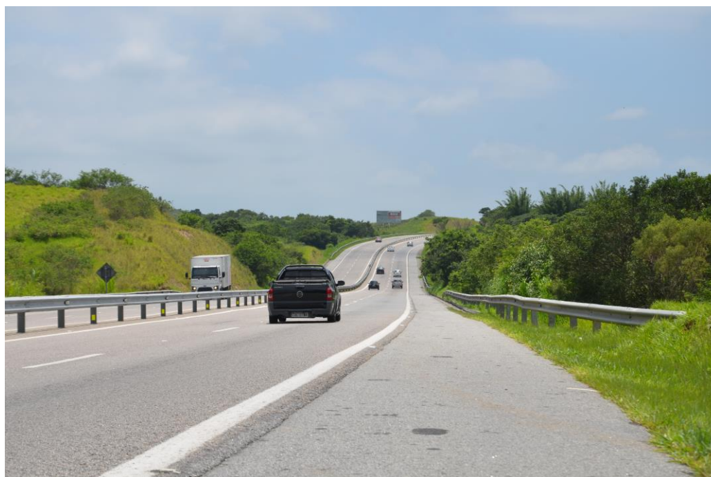
FOTO 41 – Sinalização horizontal - km 44+000
