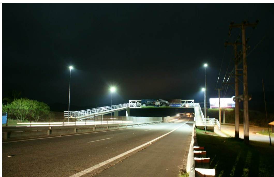
FOTO 02 - Passarela com foco na iluminação - Km 10+000
