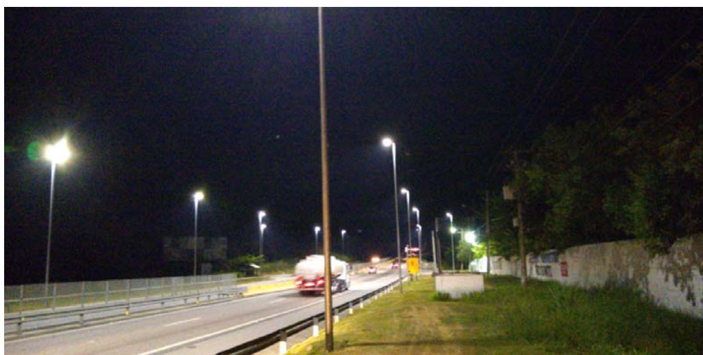
FOTO 06 – Travessia de pedestre com foco na iluminação - Km 09+000
