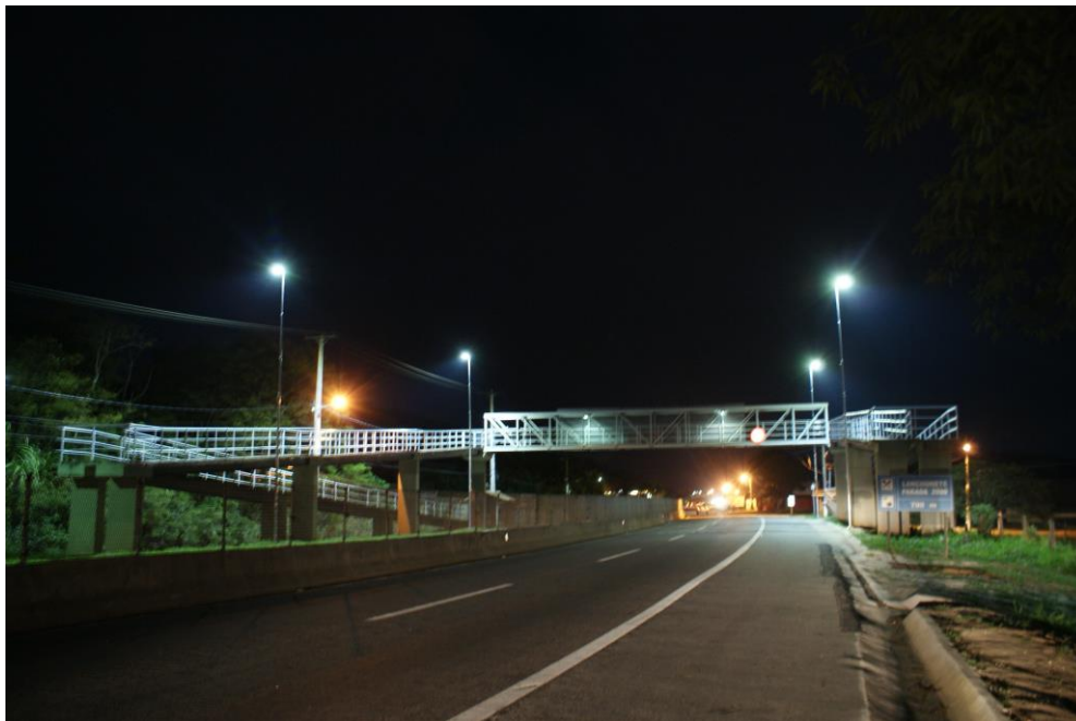
FOTO 03 - Passarela com foco na iluminação - Km 13+000
