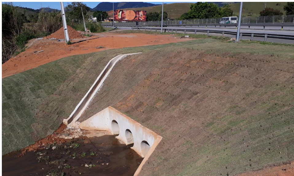
FOTO 36 - Obra de ampliação do sistema de drenagem (fim) - Km 09+370
