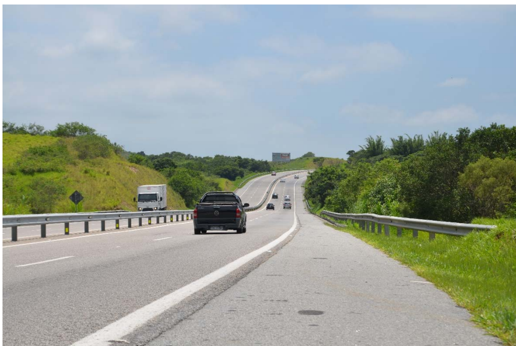
FOTO 30 – Sinalização horizontal - km 44+000
