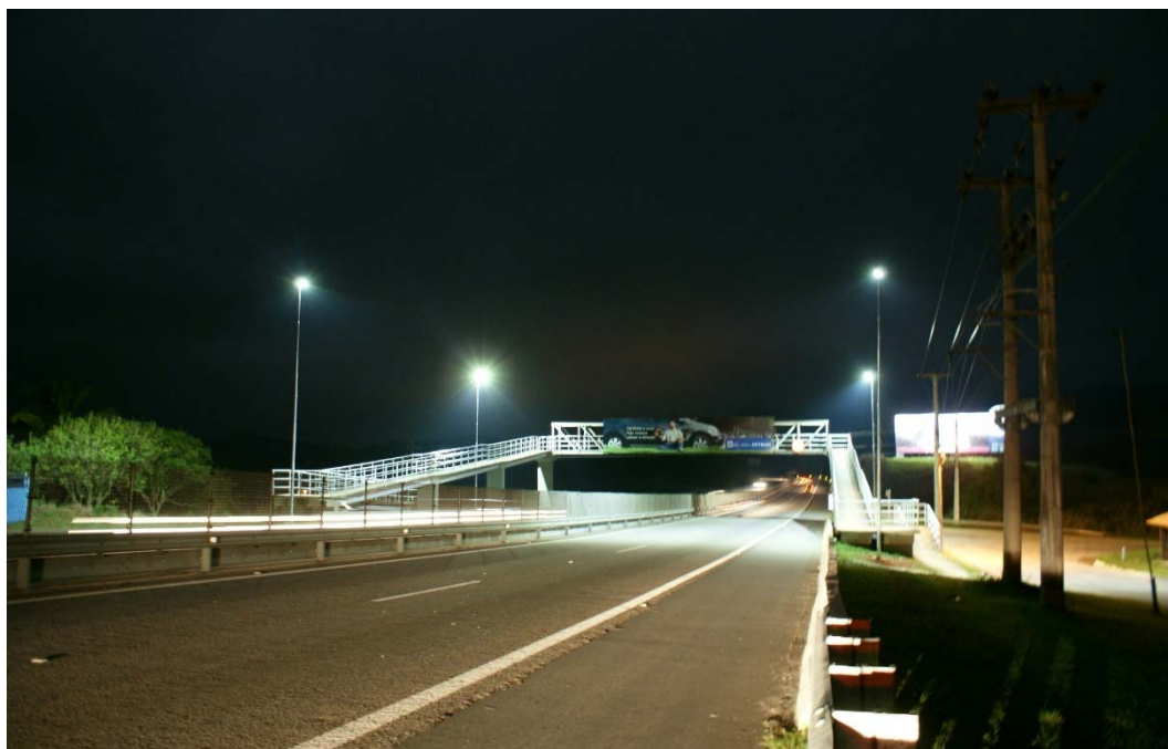
FOTO 02 - Passarela com foco na iluminação - Km 10+000
