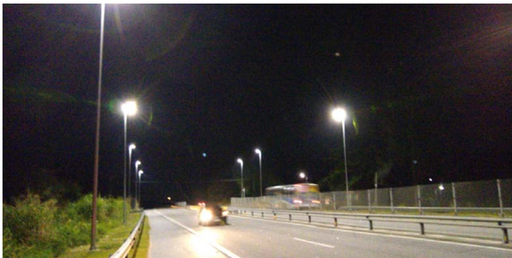
FOTO 04 – Travessia de pedestre com foco na iluminação - Km 05+000
