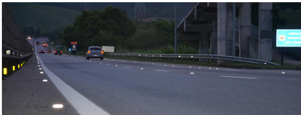
FOTO 24 – Sinalização horizontal, vertical e sinalização refletiva - km 12+000
