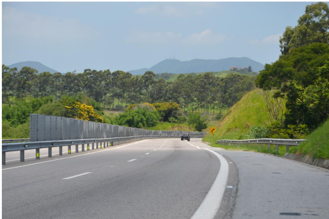
FOTO 42 – Sinalização horizontal - km 42+000
