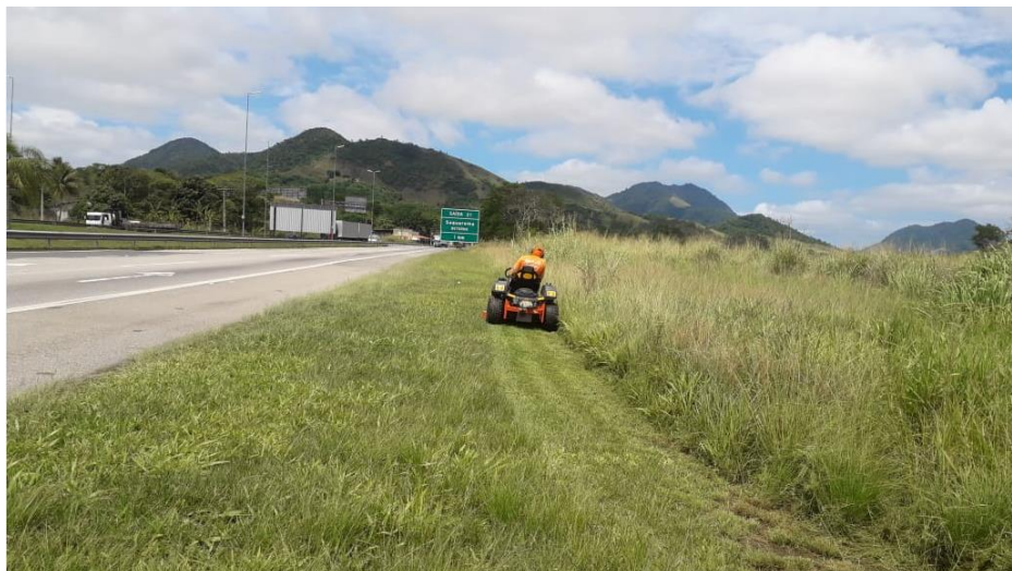
FOTO 28 – Serviço de conserva na faixa de domínio – km 23+000
