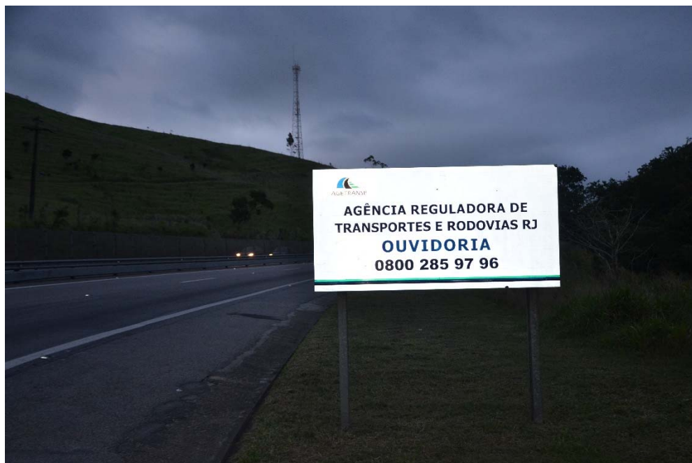
FOTO 25 – Sinalização horizontal, vertical e sinalização refletiva - km 09+000
