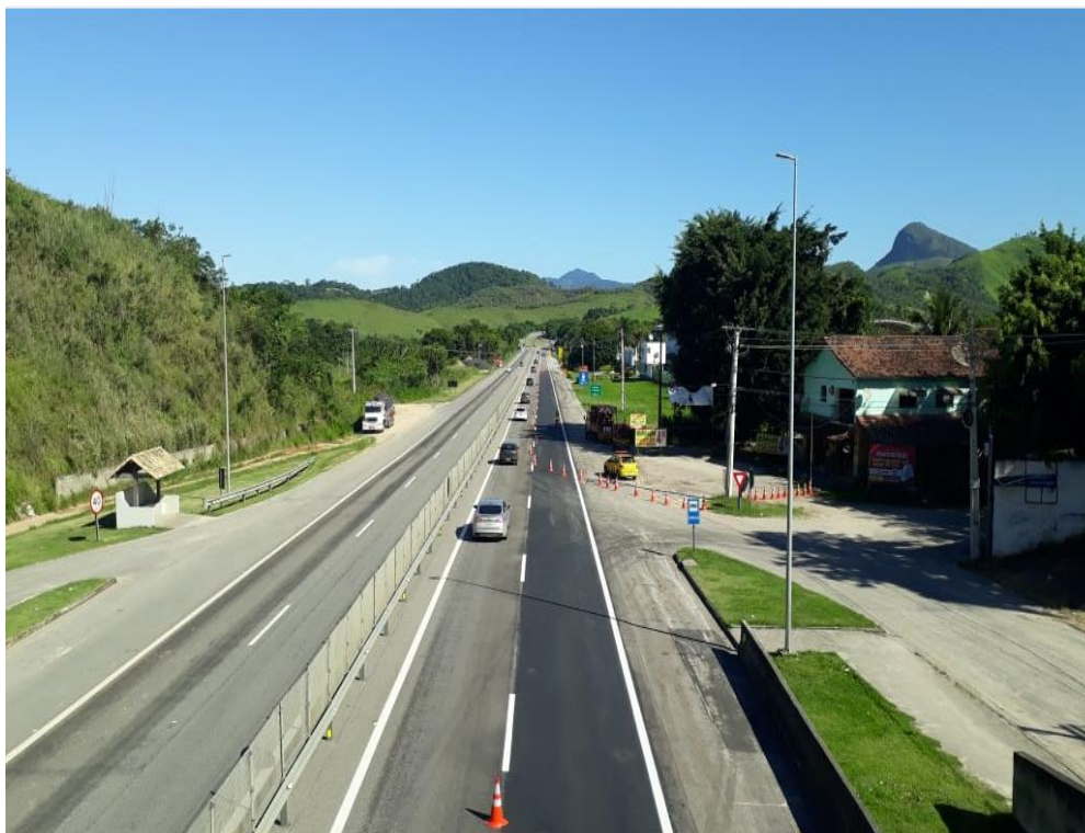
FOTO 37 - Sinalização de segurança obra de Recuperação do Pavimento - Km 3+500
